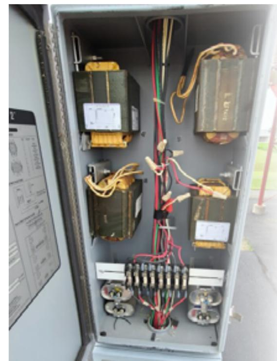
1. **Reconfigurer le câblage pour alimenter les circuits de dérivation directement jusqu'aux luminaires.**
